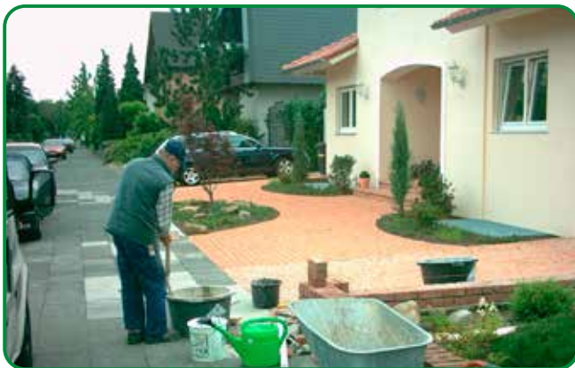
Gartenbau · Pflasterarbeiten Abbrucharbeiten
