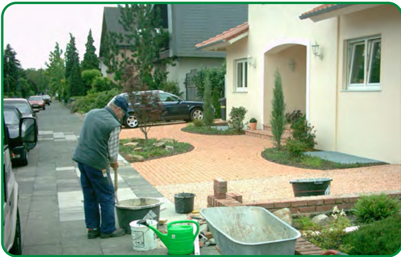
Gartenbau · Pflasterarbeiten Abbrucharbeiten
