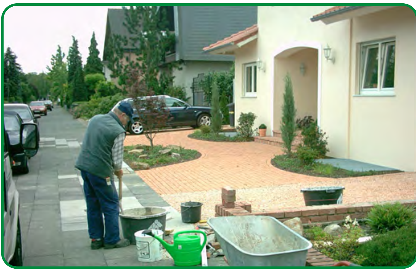
Gartenbau · Pflasterarbeiten Abbrucharbeiten
