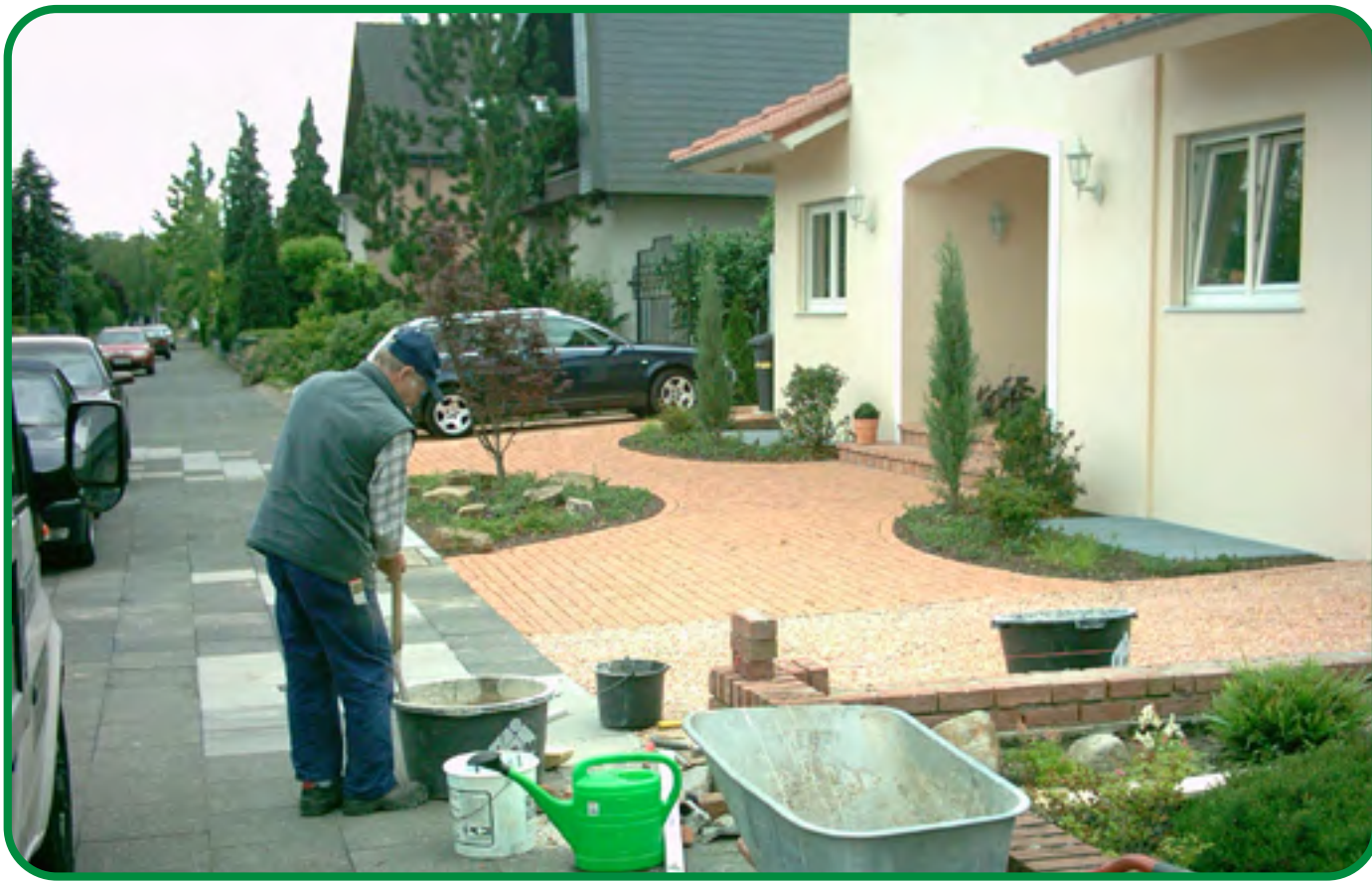
Gartenbau · Pflasterarbeiten Abbrucharbeiten
