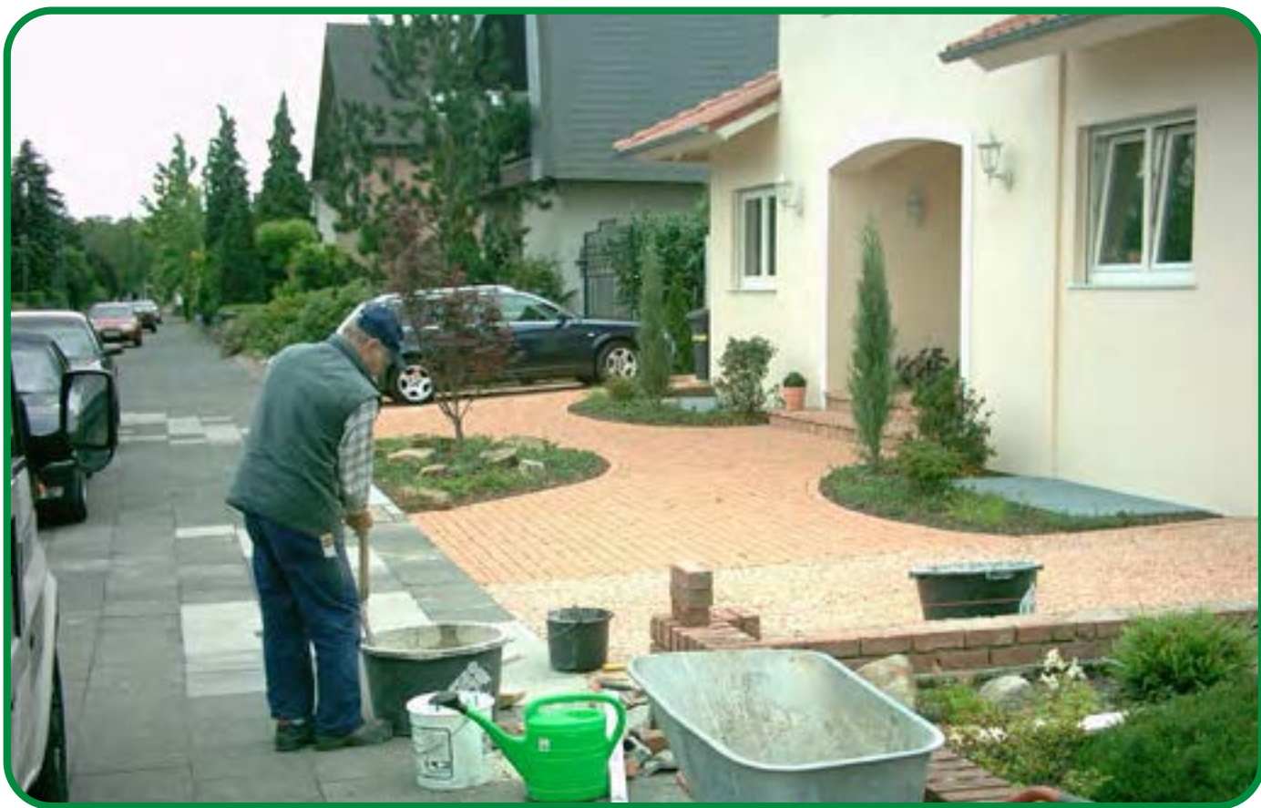
Gartenbau · Pflasterarbeiten Abbrucharbeiten
